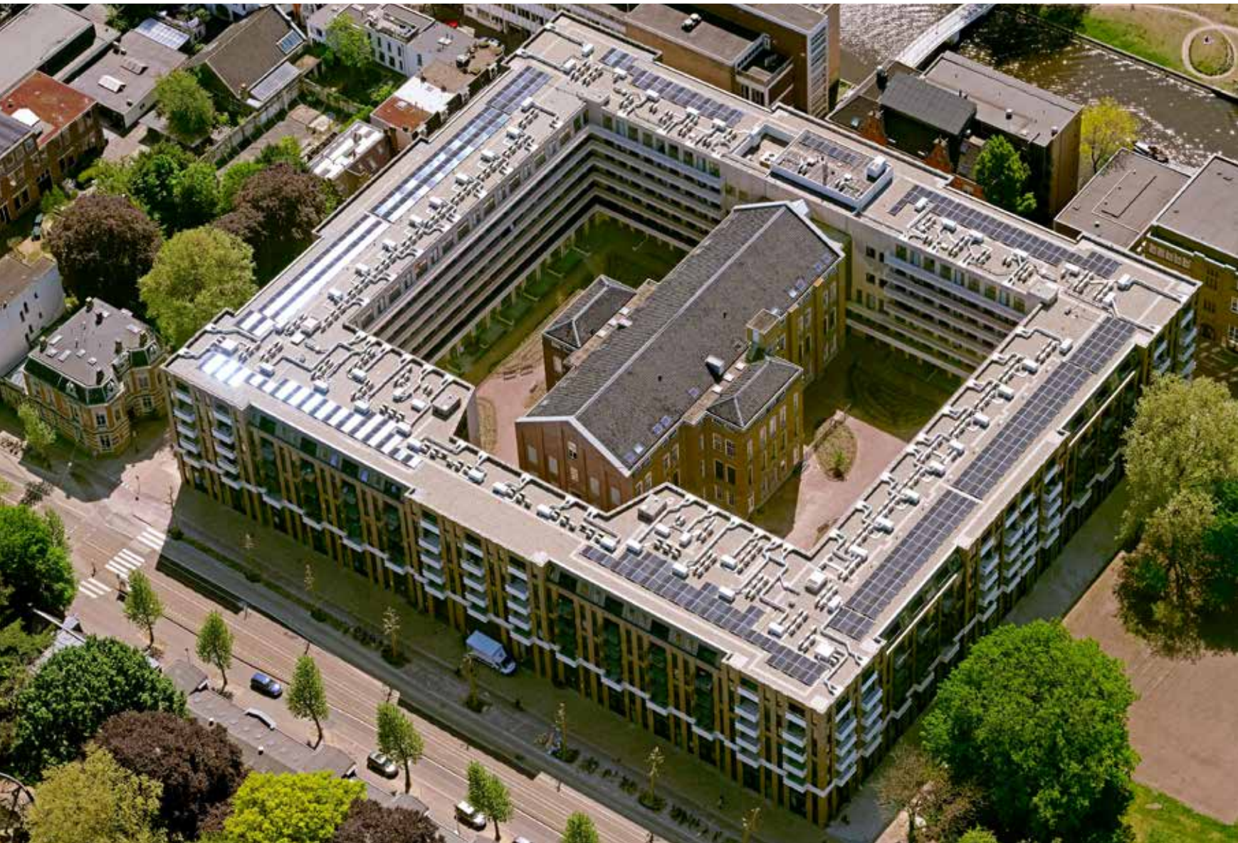
(Beeld: Façadis Gevelbouw)
